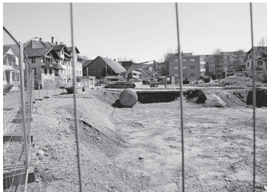
Ehemaliges Käppeli-Areal: Momentan ist die Altlastensanierung im Gang, danach wird der Bau der beiden Wohnhäuser erfolgen.
